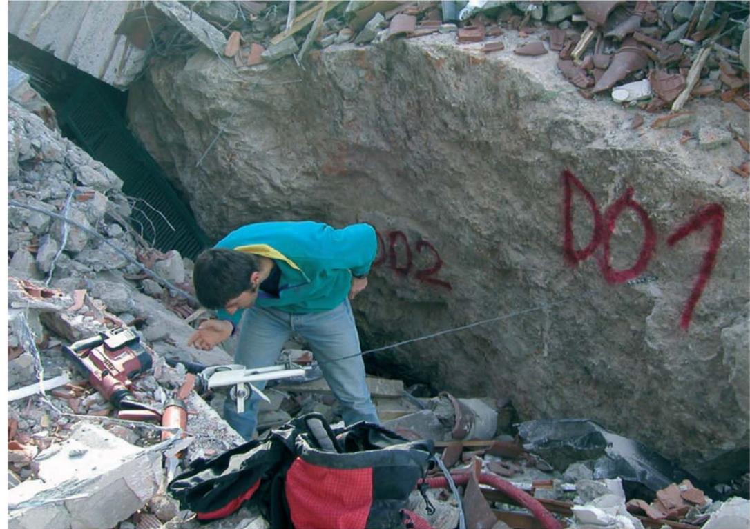
Successiva demolizione dei blocchi con iniezioni di tipo chimico
