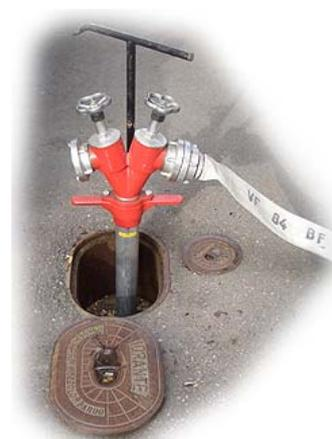
La realizzazione è disciplinata dalla norma UNI EN 14339, devono essere marcati "CE" con l'obbligo di utilizzare il cosiddetto "collo di cigno" per il collegamento delle manichette e della lancia di erogazione.
