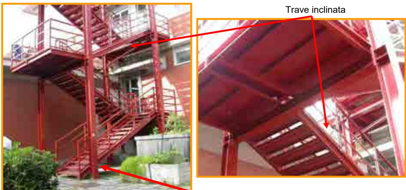
Figura 11.3 –Scale in acciaio
