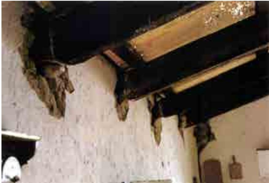
d) Lesioni delle travi principali per eccessivo sovraccarico o vetustà
