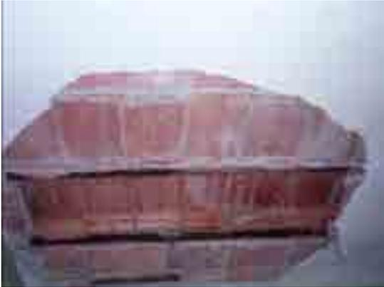
Un esempio classico di dissesto statico è illustrato a lato: si noti lo scarsissimo copriferro con la conseguente ossidazione delle barre e l'espulsione dei laterizi e dell'intonaco. Se si individuano in fase di sopralluogo casistiche del genere è bene essere cautelativi.
