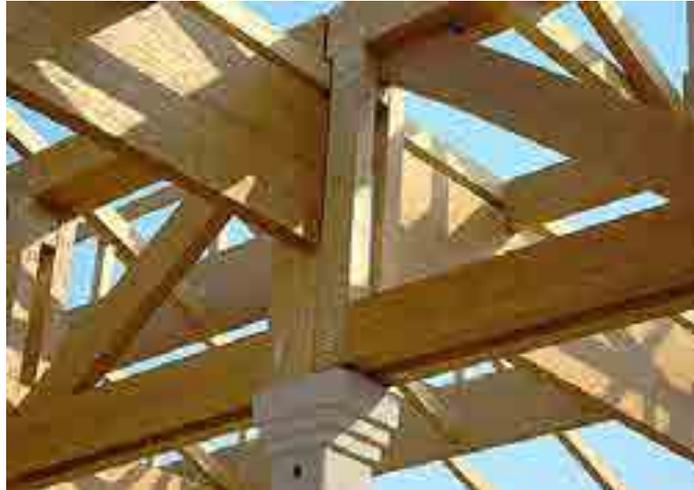
Figura 2.7 Travi in legno lamellare
