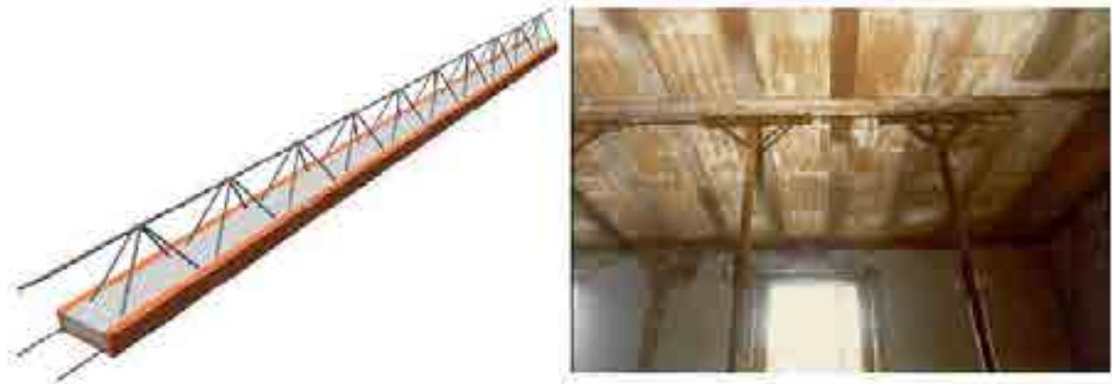
Figura 10.9 – Solai in c.a. con travetti intralicciati
