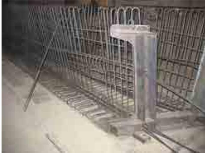
Figura 6.3 - L'armatura lenta di un tegolo in c.a.p.
