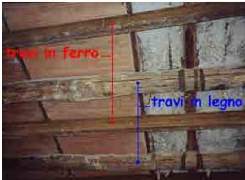
Nelle strutture prevalentemente inflesse (e quindi nei solai) possono essere presenti delle lesioni longitudinali o trasversali alle travi portanti. Se presenti in mezzeria, le seconde sono decisamente più gravi e pericolose delle prime perché denotano l'ineadeguatezza della struttura a portare i carichi strutturali. Interventi di interdizione sono quanto mai consigliati.
