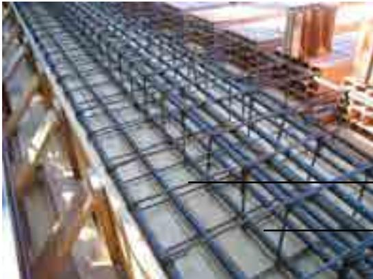
Figura 2.21 Disposizione tipica delle armature in una trave in c.a.
