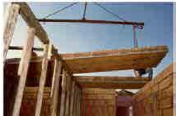
Figura 10.14 – Varo di solaio a pannelli prefabbricati
