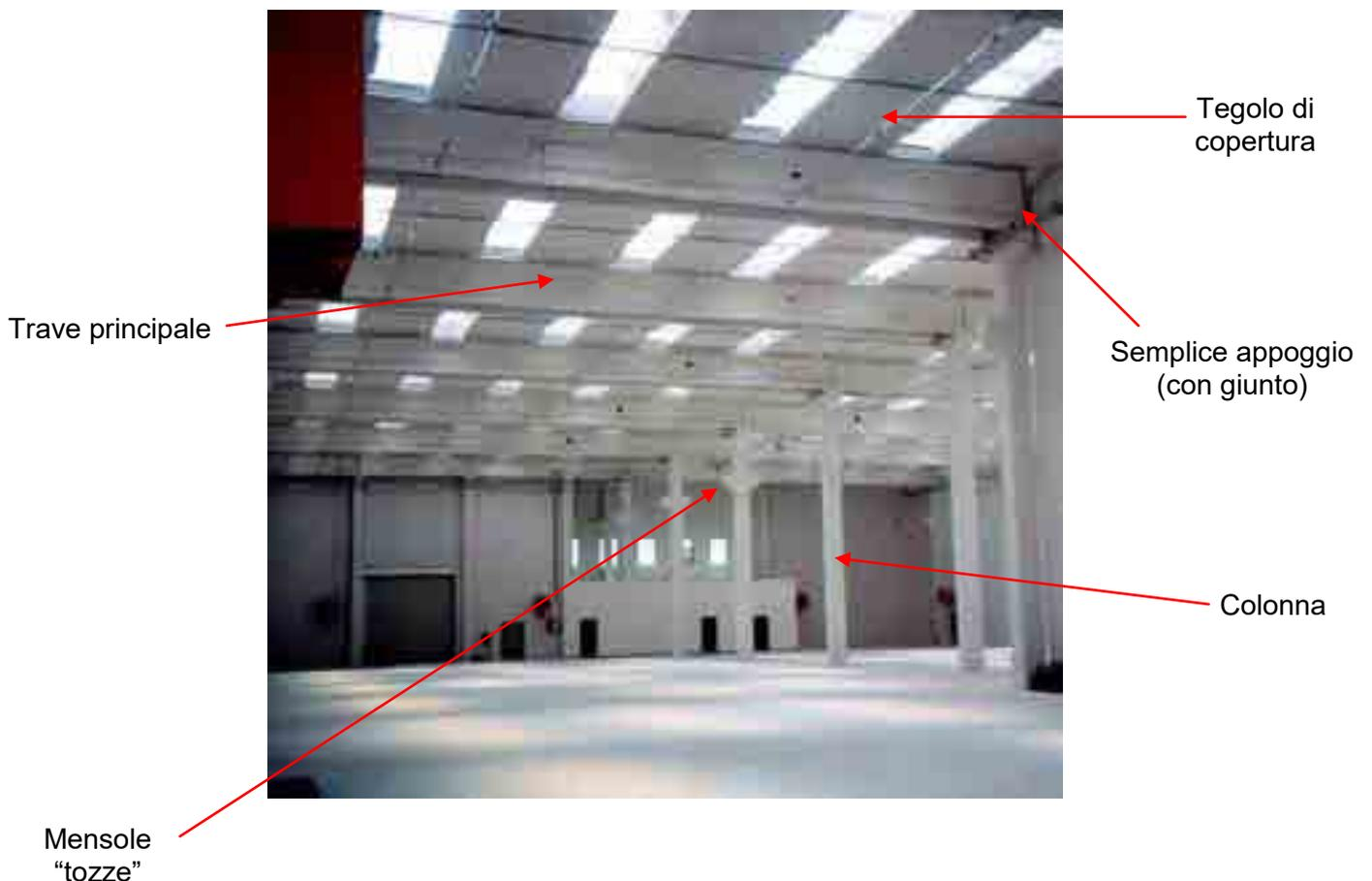
Figura 8.5 – Edificio prefabbricato in c.a.:
