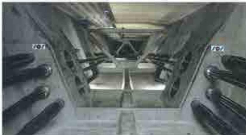
Figura 6.6 – Travi da ponte a cassone con armatura post tesa
