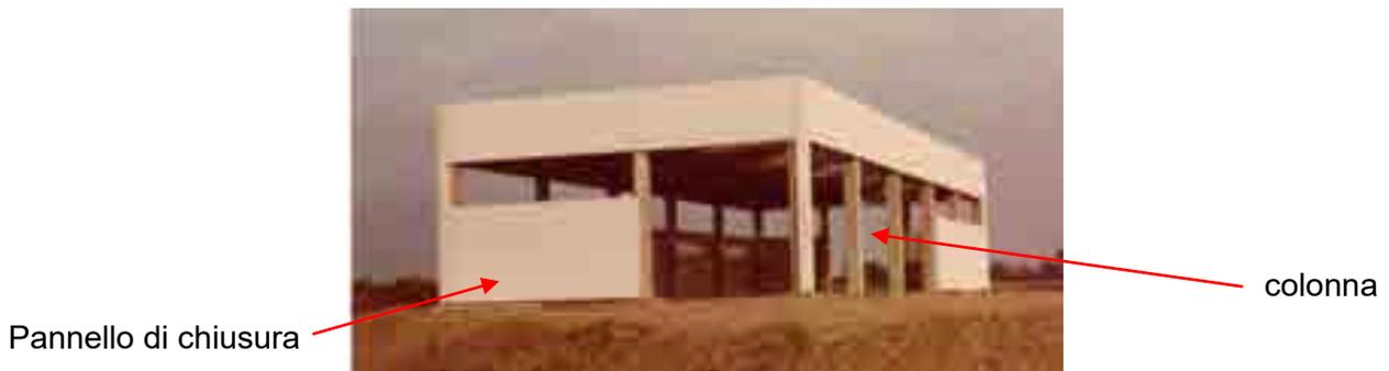
Figura 8.4 – Edificio prefabbricato in c.a.:
