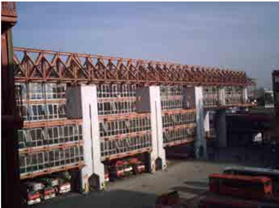
L'edificio "A" (mensa) presenta uno schema costruttivo a pianta rettangolare allungata larga circa 25 m e scandita in senso longitudinale secondo un modulo di tre metri. Si accoppiano in senso trasversale due nuclei in cemento armato con sezione a C, che contengono le scale ed ascensori. Le varie coppie di nuclei sono poste ad interasse di 18 m in senso longitudinale. Ciascun nucleo è inscritto in un rettangolo di dimensioni 3x6 mxm.
